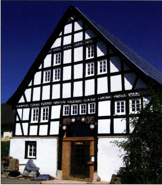
Das ehemalige Haus Krämer wird z. Zt. noch renoviert. Der ehemalige Wirtschaftsgiebel zeigt wieder sein schönes Fachwerk. Aufnahme September 2013.
